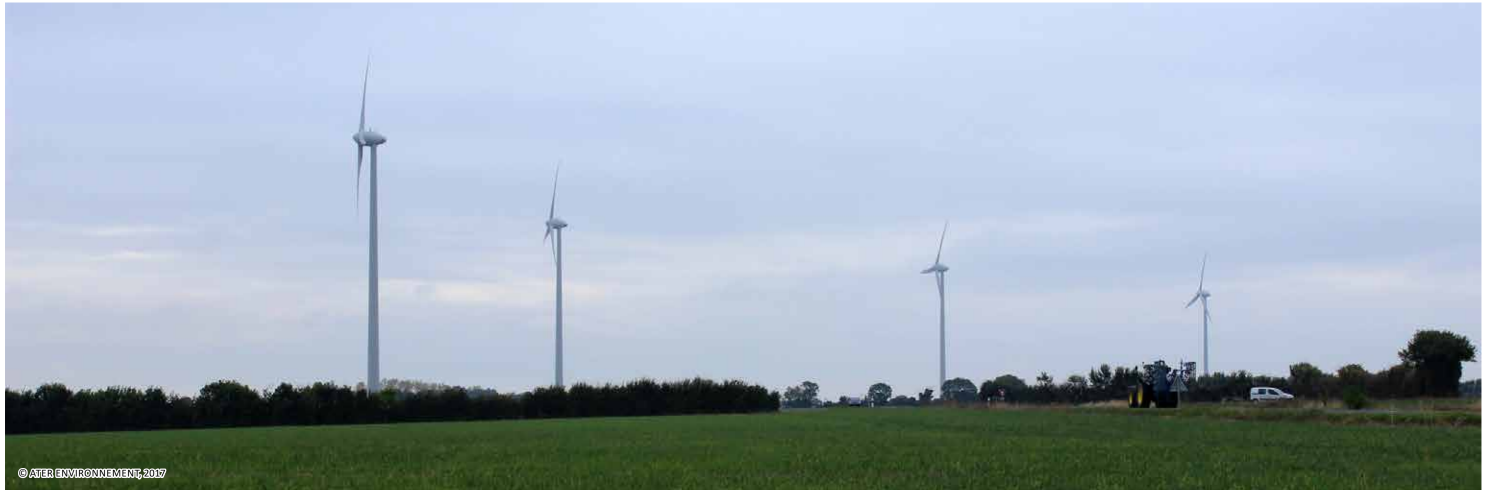
Fig. 22 : Parc éolien de Péré depuis la D939
