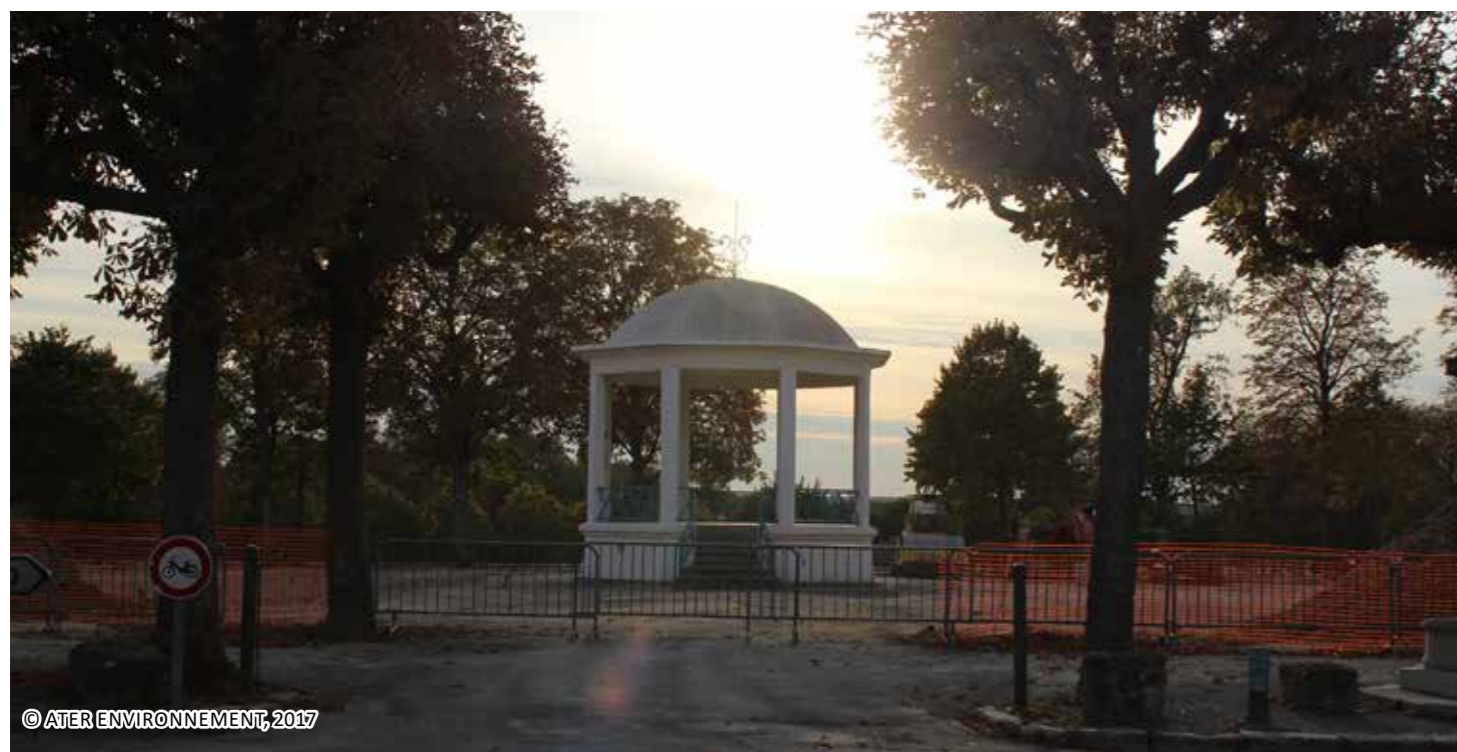
Fig. 46 : Kiosque à musique en travaux, Mauzé-sur-le-Mignon
